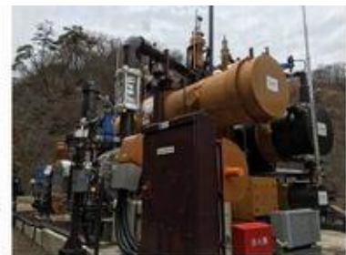
土湯温泉 16号源泉バイナリー発電所
