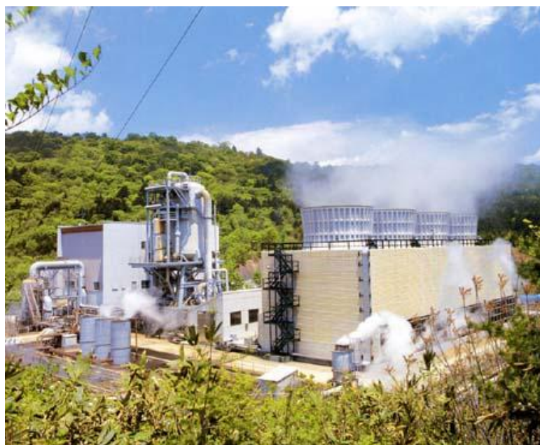
図2 現在の「鬼首地熱発電所」。出典：資源エネルギー庁
