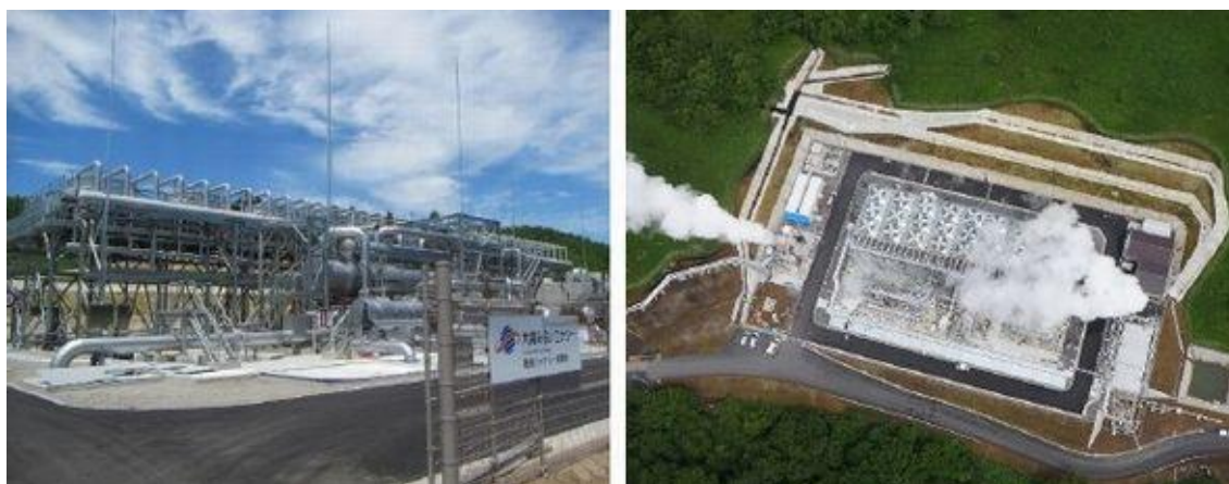
図6 「菅原バイナリー発電所」の位置(上)、発電設備(左下)と上空から見た全景(右下)。
