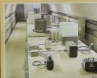
地震計室 Seismometer Vault
