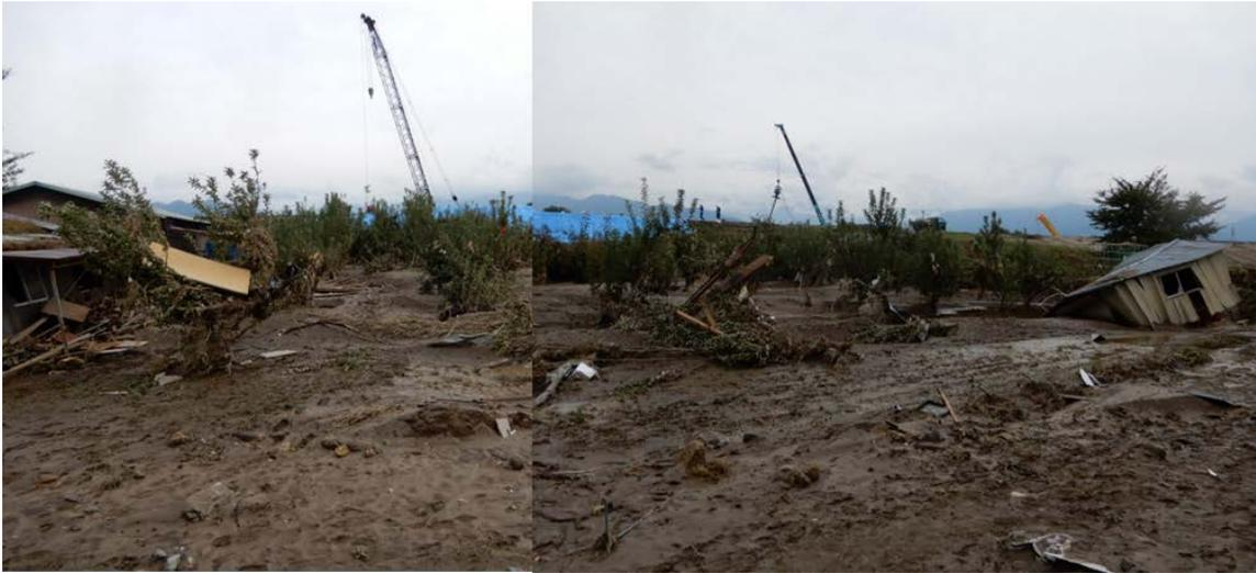
**写真5 妙笑寺南側の穂保地区の破堤箇所（応急締切終了）（2019年10月21日井上撮影）**
